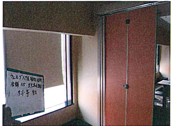
コンクリート柱型
