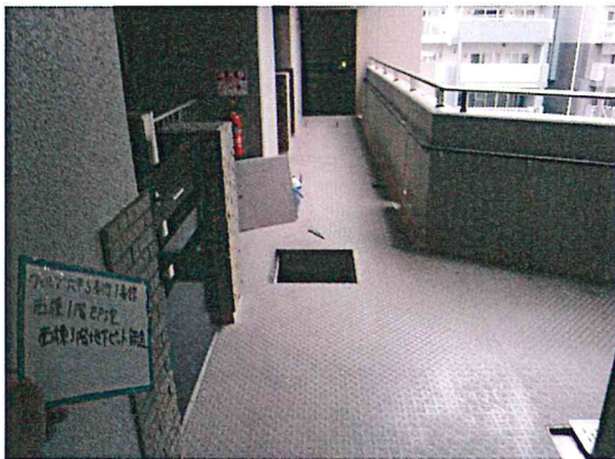
3F住居部通路、地下ピット
