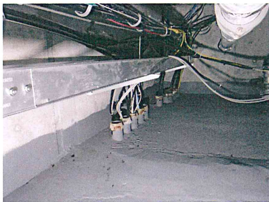
調査(上部からの侵入無し)
