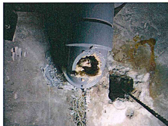
不良箇所撤去(管内石灰除去)
