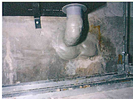
水中ボンドにて止水完了
