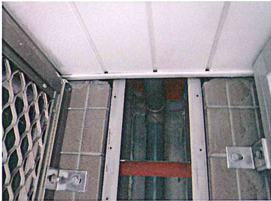
接続部異常なし
