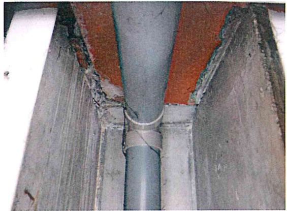
接続部異常なし
