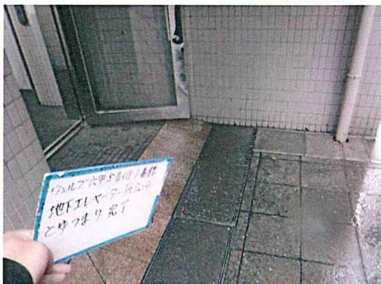
冠水状況解消
