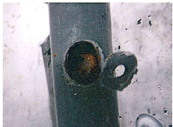
対面側穴あけ(内部状況)
