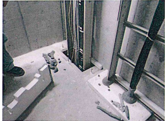
調査(上部からの侵入無し)
