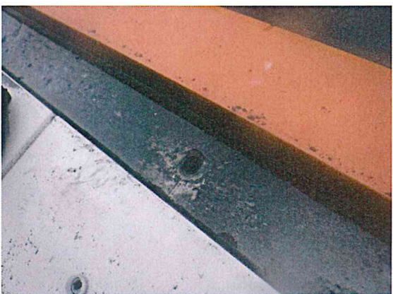
店舗115排水経路復旧
