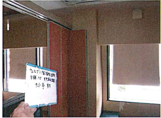
コンクリート柱型
