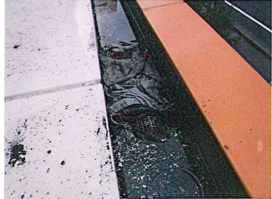
店舗115排水口異物撤去
