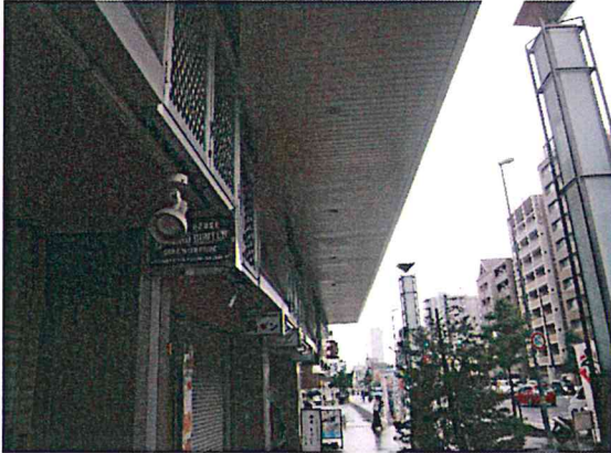
庇 排水管調査
