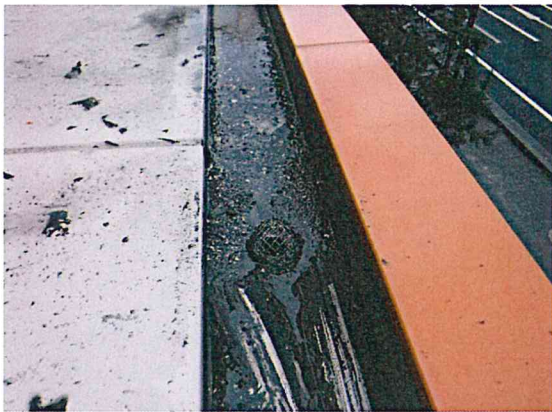
店舗115排水口異物撤去
