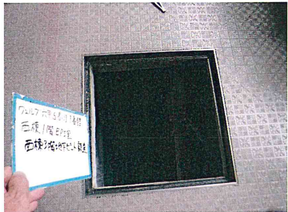
3F住居部通路、地下ピット
