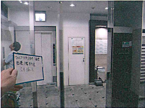
西棟 1F EPS調査
