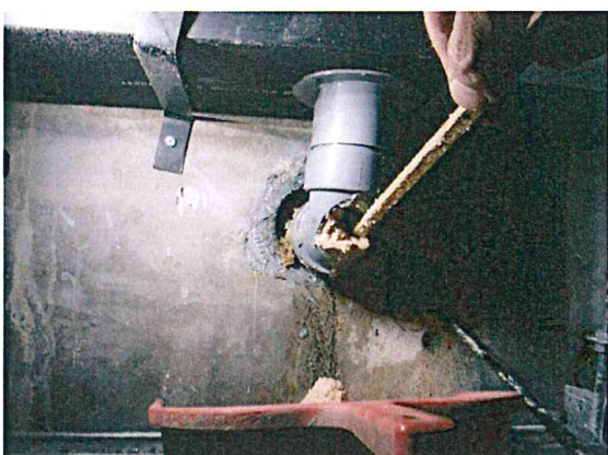
管内清掃つまり抜き
