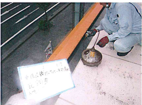
ワイヤーカンツールによる詰まる抜き
