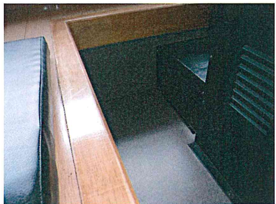
床コンパネにて床貼り
