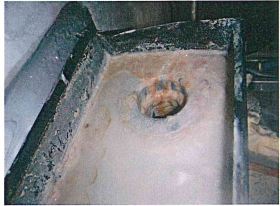
排水口異常なし
