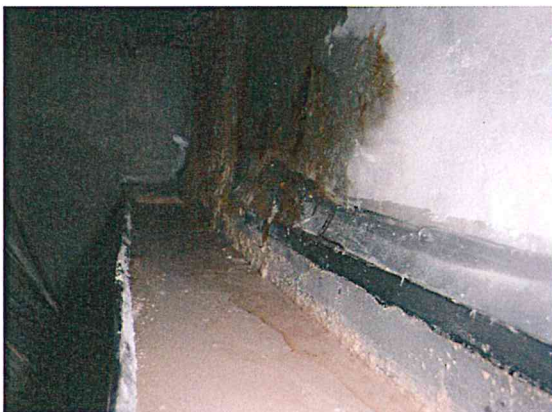
漏水受け樋異常なし
