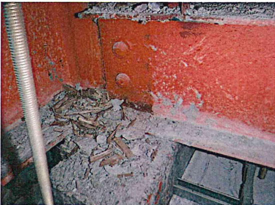
正面コンクリートに染み在り
