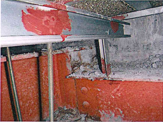
正面コンクリートに染み在り
