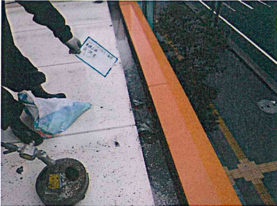
店舗115排水口異物撤去
