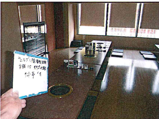
店舗117側(漏水被害店舗側)
