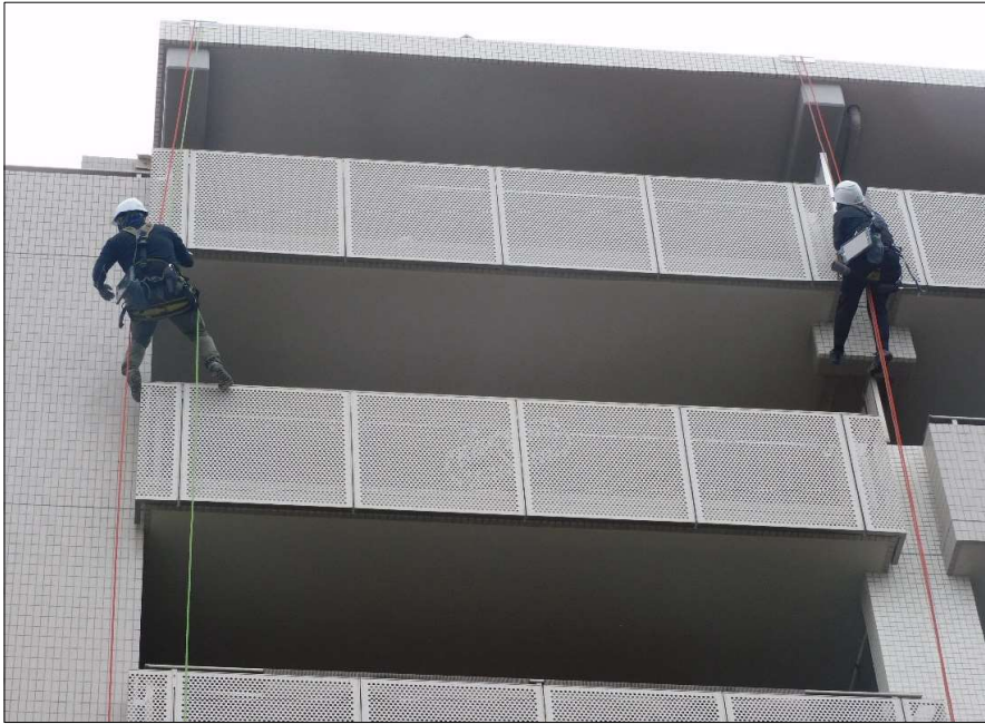
調査状況写真
