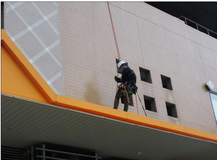
調査状況写真
