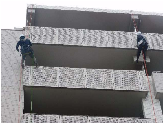
ロープアクセス工法による打診調査状況
